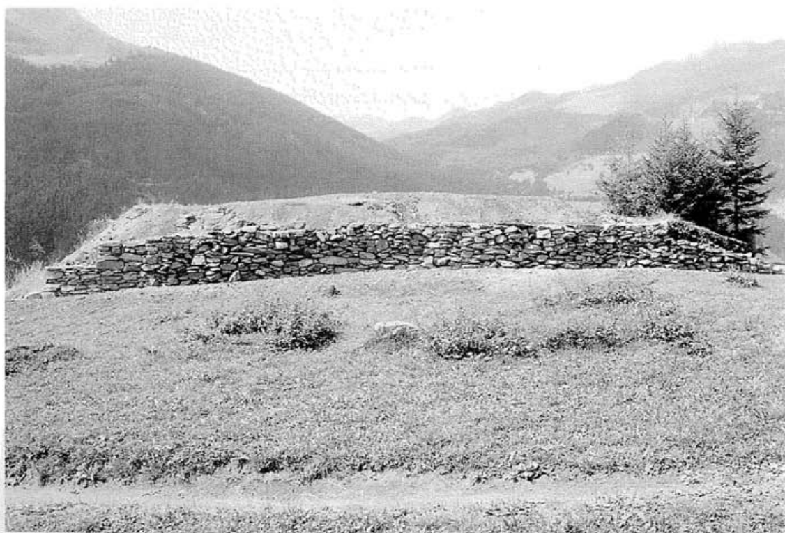
Abb. 8: Savognin-Rudnal; «Steingebäude» oder «Steinpodest» nach den Grabungen des Schweizerischen Landesmuseums Zürich. (Foto ADG).
