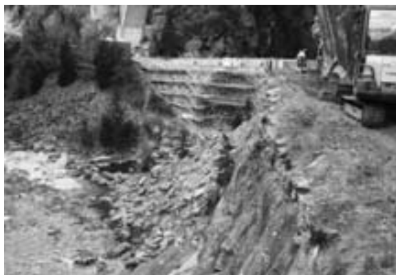
Abb. 2: Geländersäulen, Trockenmauern mit Tombini (Wasserdurchlässe) sowie diverse Brücken sind die hauptsächlichen Substanzelemente der alten Averserstrasse (GR 780.2.10) (Foto: Fredi Bieri, 2006).
