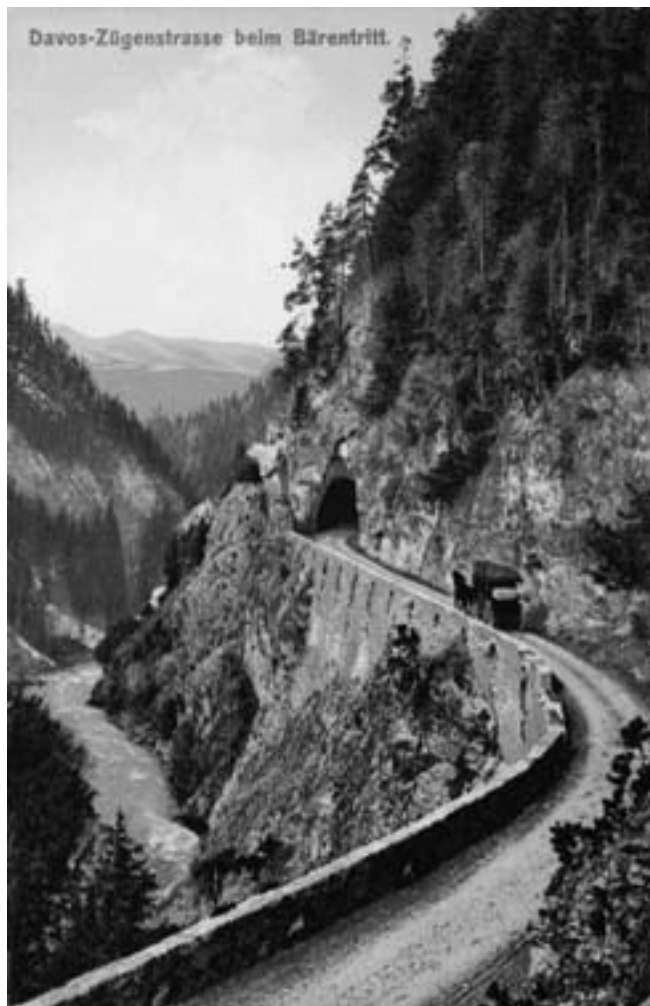
Abb. 1 (linke Seite): Alte Zügenstrasse (GR 41.4.1) beim «Bärentritt» am westlichen Eingang in die Zügenschlucht. Das Trasse wird von einer hohen, auf anstehendem Fels gemauerten Stützmauer gehalten (Heike Buchmann, 2006).
