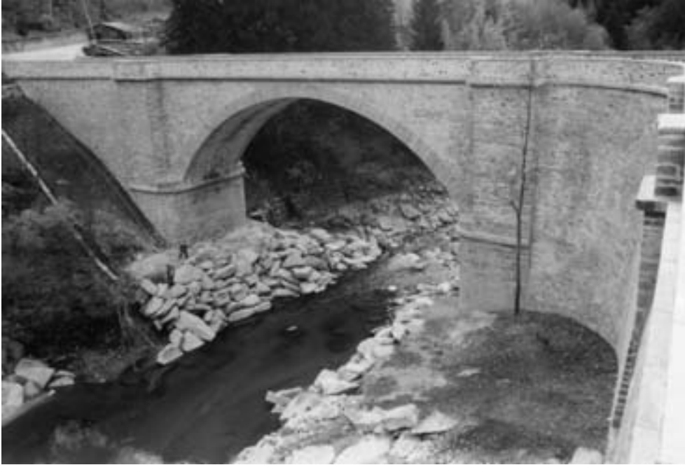
Abb. 1: Die Rania-Brücke über den Hinterrhein beim südlichen Eingang der Viamala nach der Instandsetzung von 1986 (s. Seite 42).
