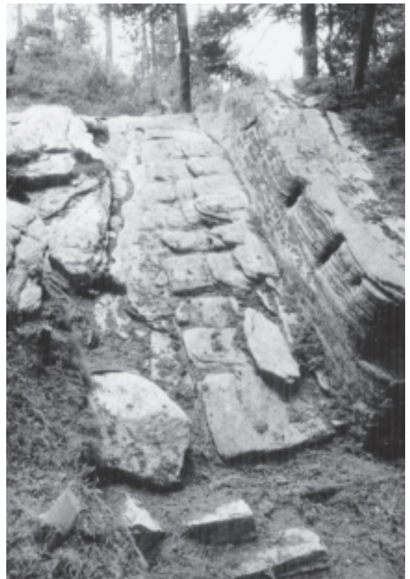
Abb. 1: Stampa-Maloja, Malögin: Wagenrampe mit Karrengeleisen und Querstufen (Bildquelle: Archäol. Dienst Graubünden).
