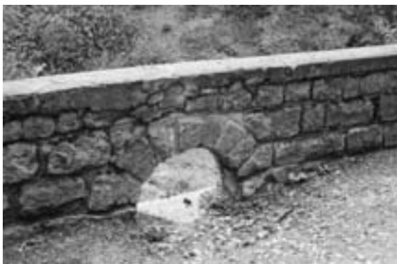
Abb. 5 (oben): Alte Zügenstrasse (GR 41.4.1). Brüstungsmauer Typ 1, bestehend aus kleinen Steinen aus dem Felsabtrag. Vermutlich die Originalbrüstung, welche nachträglich verputzt worden ist (Heike Buchmann, 2006).
