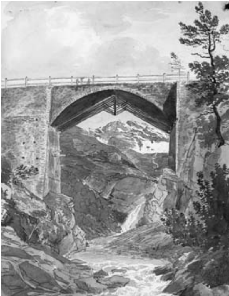
Abb.3: Aquarell (ca. 1824, vermutlich von Richard La Nicca) mit der Königsbrücke, «il ponte Reale Vittorio Emanuele». Die Abbildung (Blickrichtung flussaufwärts) zeigt das erste, von Pocobelli erbaute Brückengewölbe.
