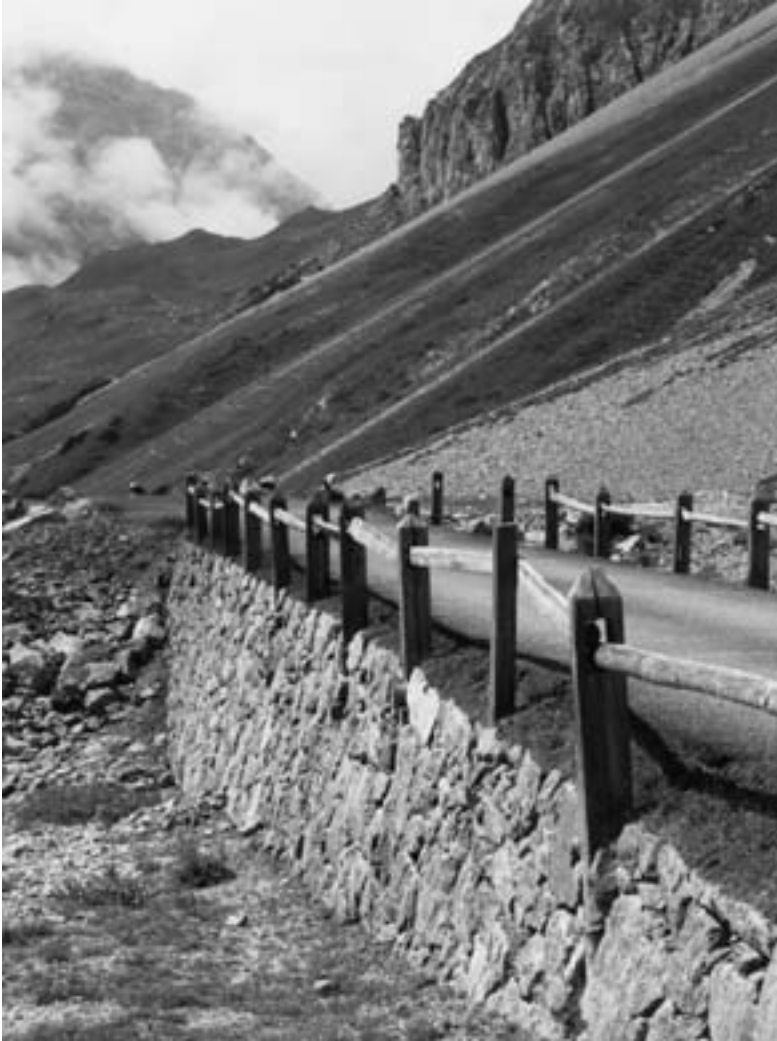
Abb. 13: Ganz ohne Bindemittel wurden Kunstbauten im 19. Jahrhundert erstellt, wie hier der Dammaufbau mit aufgerichteter Bruchsteinmauer am Albulapass (Foto: Schweizer Verkehrszentrale).
