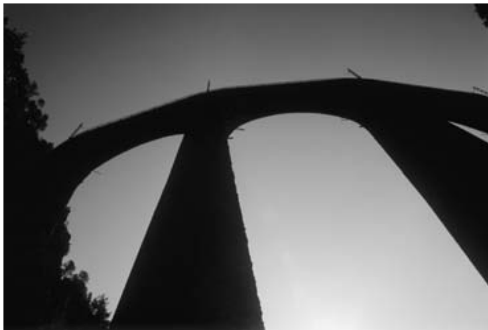
Abb. 2: Mit einem Radius von lediglich 100 Metern werden beim Landwasser-Viadukt die Normmasse von 120 Metern unterschritten (Bild: Mathias Kunfermann, demateo AG, Thusis).
