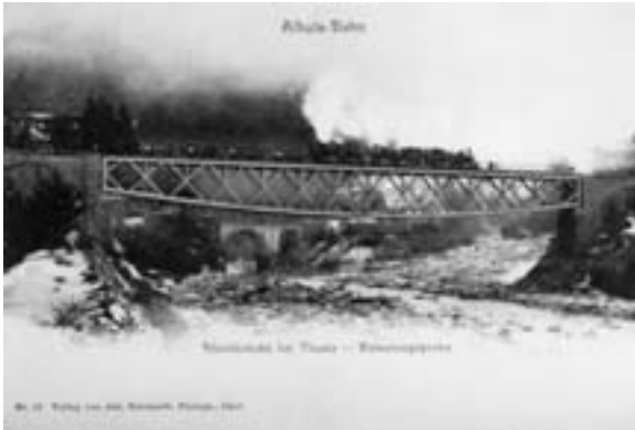
Abb. 3 (oben): Belastungsprobe auf der Fachwerkbrücke bei Thusis (Bild: RhB Archiv, Chur).
