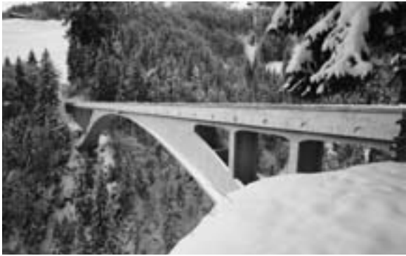
Abb. 5 (oben): Maillarts Salginatobelbrücke (GR 542.2.2) wurde 1991 zum «Internationalen Historischen Wahrzeichen der Ingenieurkunst» ernannt (Bild: Mathias Kunfermann, demateo AG, Thusis).
