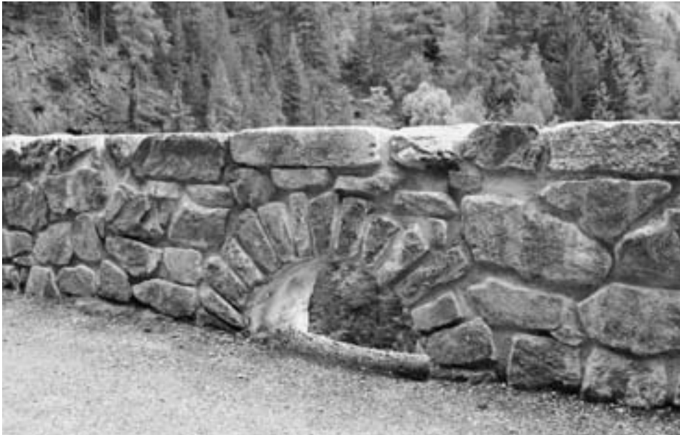
Abb. 8: Alte Zügenstrasse (GR 41.4.1). Neuer Brüstungsmauertyp, nach dem fehlende oder nicht mehr zu sanierende Brüstungsmauern seit dem Jahr 2000 ersetzt werden (Heike Buchmann, 2006).
