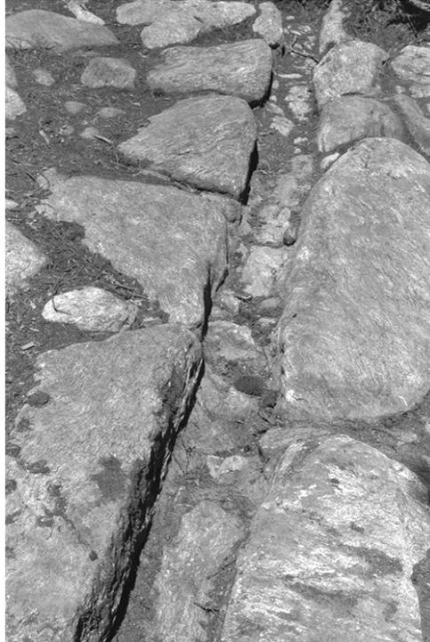
6: Durchgehend gepflastertes Teilstück mit talseitiger Trockenstützmauer von 1-1.5 m Höhe, teilweise markanten Randplatten und talseitigen Randsteinen. Die bergseitige Böschung ist nur schwach ausgeprägt. Der Weg verläuft etwas höher als das heutige Fahrsträsschen. Um die Verbindung mit dem folgenden Teilstück des historischen Weges zu ermöglichen (Kroki: 8), wurde anlässlich der Sanierungen 1990 eine Steintreppe gebaut (vgl. „Ziele und Massnahmen“).
