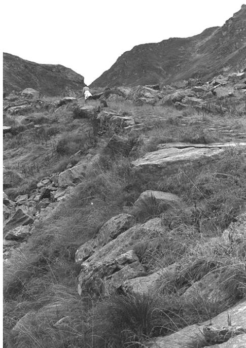
7: Cranch da Sett: 500 m langes Wegstück mit teils berg- und teils talseitiger Stützmauer von 1.5 m Höhe. Das Trassee ist gut 3 m breit, gepflastert mit oft sehr grossen Randplatten und weist gegen den Abgrund (Tobel) Randsteine auf. Der leicht rutschende Hang verschiebt die Stützmauern. Die Pflasterung und die Stützmauern sind generell in schlechtem Zustand (überwachsen, ausgespült, verschoben).
