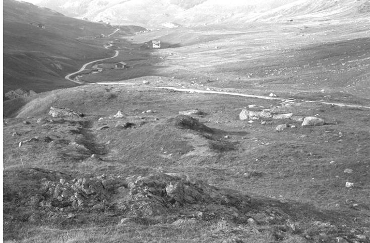
2: Felsdurchbruch mit mehreren Metern Böschungshöhe. Für das Fahrsträsschen wurde der leicht zu bearbeitende Fels an dieser Stelle weiter ausgesprengt. Frühere Varianten scheinen aber auch schon hier durchgeführt zu haben. Allerdings ist auch eine Fussspur ausserhalb dieser Enge über dem Bach sichtbar. Sie ist – relativ chronologisch gesehen – älter als die Hohlwegspuren.
