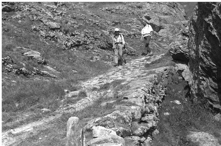
8: Der vom Säsel bis zur Furt (Pkt. 2073) führende Abschnitt ist durchgehend gepflästert und mit Querabschlägen und Randsteinen versehen. Wegbreite rund 3 m mit auffallend grossflächigen Randplatten. Die Böschung ist unauffällig bis inexistent. Die
