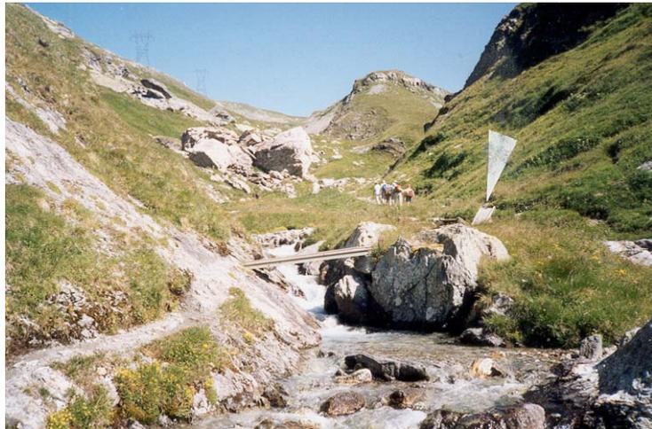
6: Von der neuerbauten Brücke bis zum Säsel: Meist gepflasterter, 2 - 3 m breiter Weg mit langen, schweren Randplatten und einigen Randsteinen. Geputzte bzw. neu angelegte Querabschläge. Der Weg ist an mehreren Stellen vom Bach zerstört oder durch Hangwasser überspült, die Pflasterung teilweise aus- oder weggespült.
