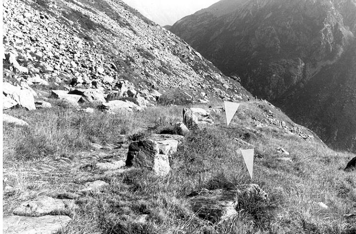
*Die aus groben Steinblöcken bestehende Trockenstützmauer leidet unter dem Steinschlag vom Piz Blanch und unter der Nässe.
