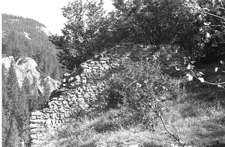
10: Nach der Rüfe bis zur neuen Brücke des Fahrsträsschens. Anfänglich unter Schutt bedeckt, werden anschliessend Reste einer 0.5 m hohen Stützmauer sichtbar. Die Wegoberfläche ist Grasnarbe oder Rüfenschutt.
