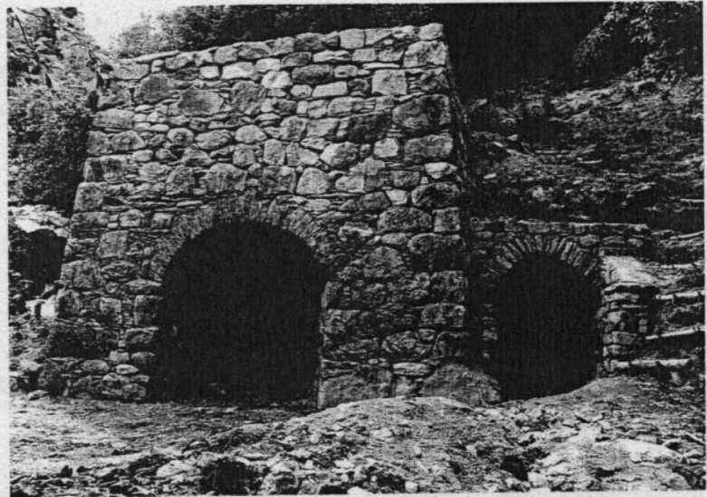
Flossofen nach durchgeführter Sanierung.
